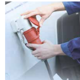
Anschluss für Baustellenstrom
